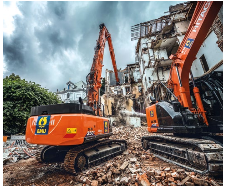
Wenig Platz zum Rangieren hatte der Longfrontbagger der BMU bei dem Abriss eines vierstöckigen Wohnhauses im Münchener Stadtteil Lehel.
