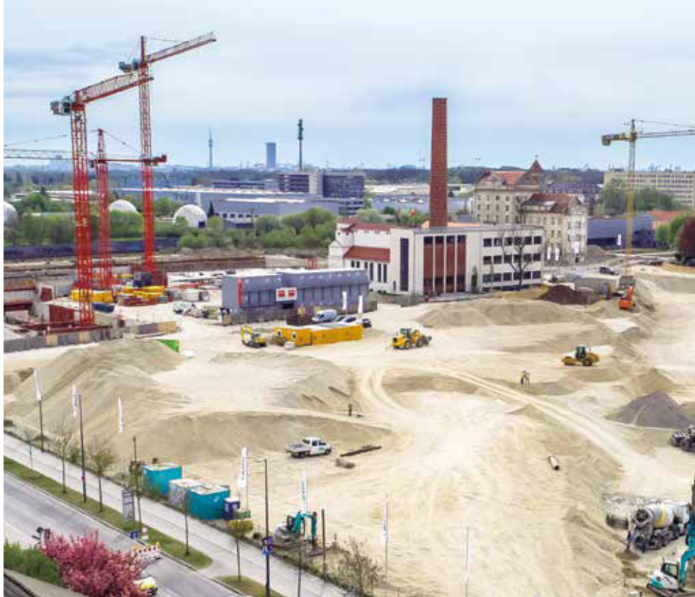
Das Diamant-Projekt ist derzeit das größte Bauvorhaben im Münchner Stadtbezirk Allach-Untermenzing. Um das ehemalige Gelände des Backmittel-Herstellers bebaubar zu machen, führte Bauer Umwelt umfangreiche Sanierungsarbeiten aus.
